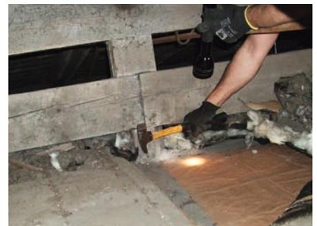
Der bestehende Ringanker wurde betontechnisch saniert und durch einen zusätzlichen dünnen Ringanker ergänzt, an den die neuen Zuganker angeschlossen wurden. Alle zusätzlichen Bauteile wurden weitestgehend reversibel und »begebar« ausgeführt.
