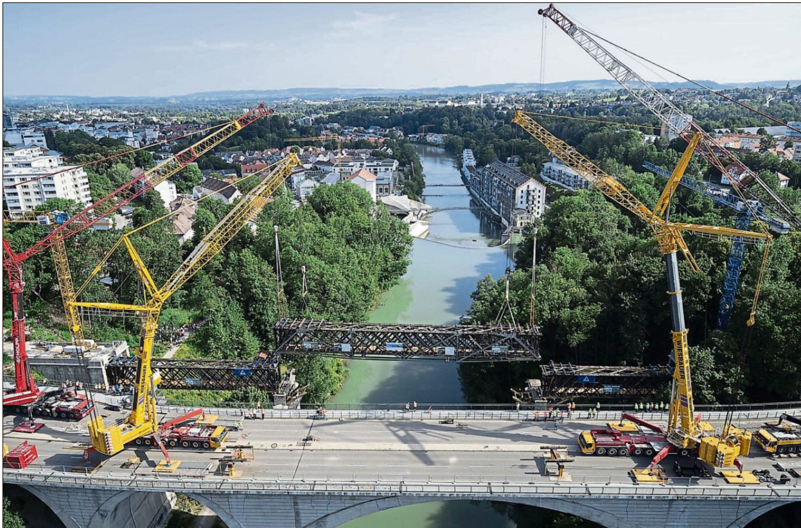
Einhub des 140 Tonnen schweren Mittelteils der König-Ludwig-Brücke mit vier Kränen.
