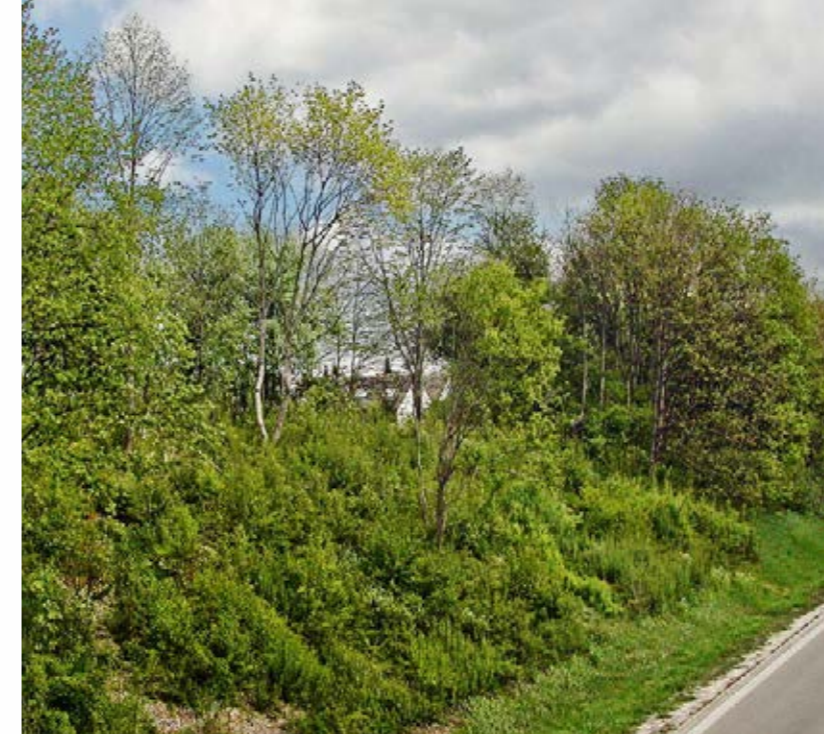
Böschung mit Bäumen und Sträuchern mit Neuaustrieb im ersten Jahr nach einer grundhaften Gehölzpflege
