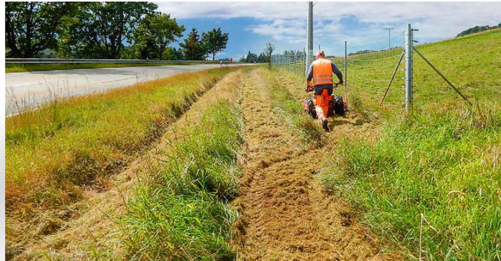
Eine Wiesenfläche im Extensivbereich, die bisher mit einem Handschlegelmäher gemulcht wird, kann durch Einsatz schonender Geräte, durch Mähgutabfuhr und optimierten Mähzeitpunkt zu einer Auswahlfläche mit blütenreichem Magergrünland entwickelt werden.
